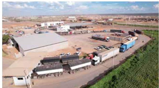
Caminhão de soja sendo seguido na entrada da instalação de esmagamento da Bunge em Luís Eduardo Magalhães
